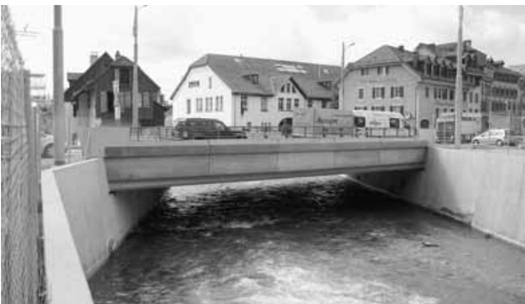
Während fast zwei Jahren eine Baustelle: Die Brücke in Bözingen.
